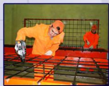
Полигон арматурных работ
