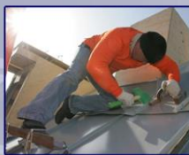
Полигон кровельных работ
