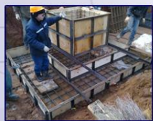
Полигон бетонных работ
