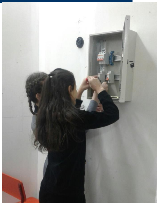
Монтаж рабочего щита освещения
