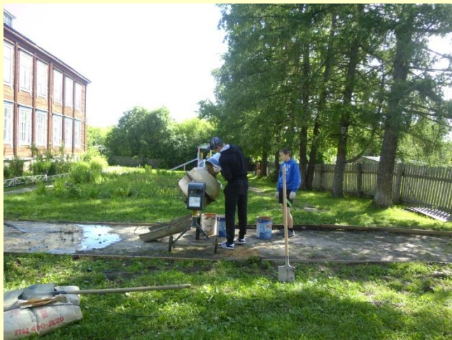
Мальчики начали работу по заливке бетонной дорожки у парадного входа в здание школы.
